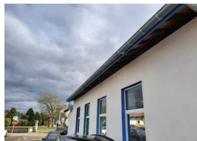
10 Mise en place des gouttières du pôle ados et nettoyage du pied de mur.
