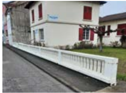
2 Refection de la balustrade de la bibliothèque
