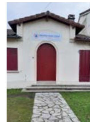
14 Tartas accueil et Protection Civile : changement des portes
