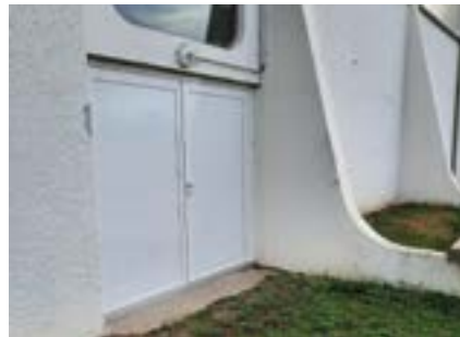
8 Remplacement de la porte d'entrée du Gymnase
