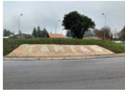
1 Rénovation du rond point de l'entrée est de Tartas
