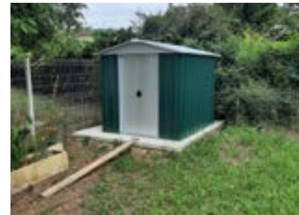
9 Montage d'un cabanon de jardin à l'école
