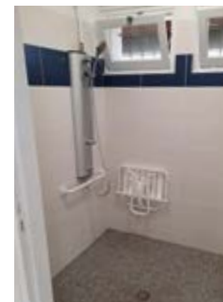
15 Travaux ERP tennis et club du 3e âge
