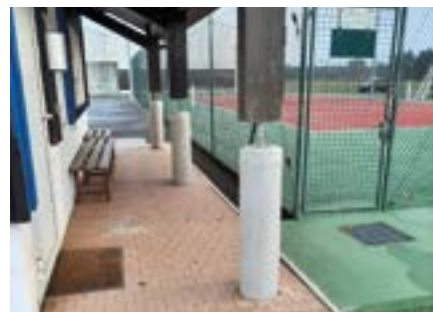
4 Réparation des poteaux en bois au club-house du tennis
