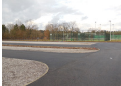
Places de stationnement supplémentaires avec accessibilité PMR
