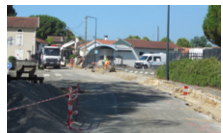
Travaux rue Jules Ferry.
